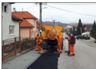
Záverečná oprava krajnice
