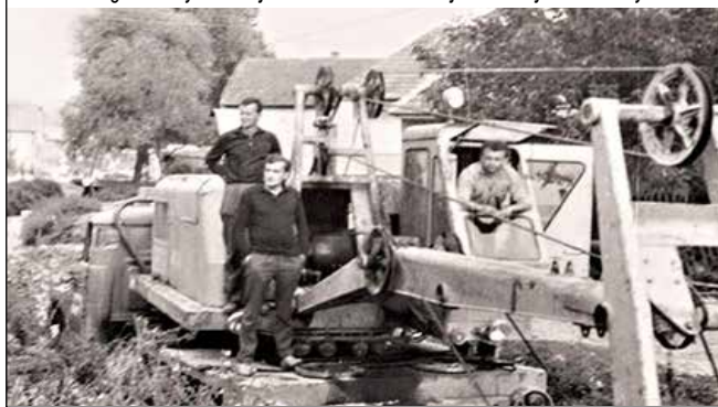
Bager v koryte - strojník Sorád z Jelenca - jeden stroj na 3 stavby
