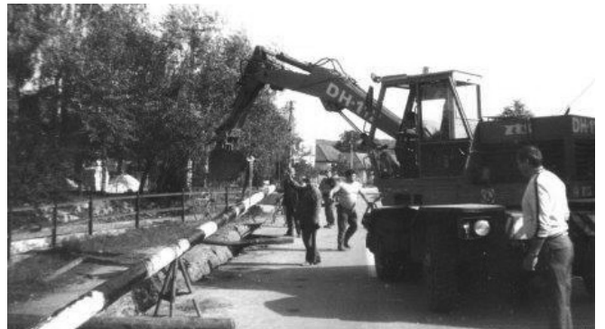
Práce na plynofikácii obce.
