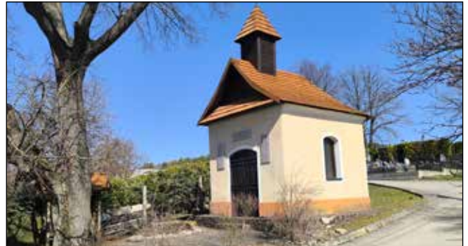
Rekonštrukcia strechy na Kaplnke sv. Vendelína
